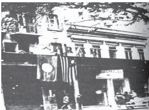
Fig. 23 - Fachada do edifício sede da PRAR - Rádio Sociedade Record de São Paulo. A rádio da Revolução de 1932.
