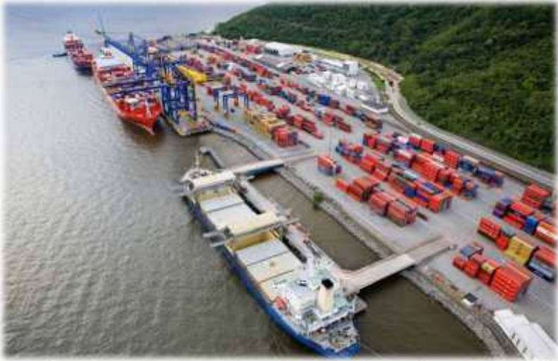
Na região existem quatro portos de grandes dimensões: Rio de Janeiro, Sepetiba (foto), Vitória e Tubarão, com intenso movimento de navios e alto percentual de movimentação do comércio exterior.
