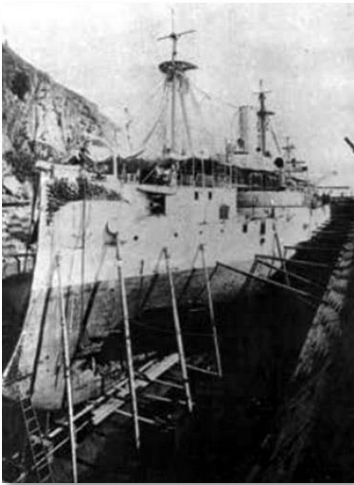
Fig. 14 - O encouraçado Aquidabã após torpedeamento, em reparo em dique da Ilha das Cobras, Rio de Janeiro. O rombo no costado provocado pelo ataque da torpedeira Gustavo Sampaio é visível na proa.
